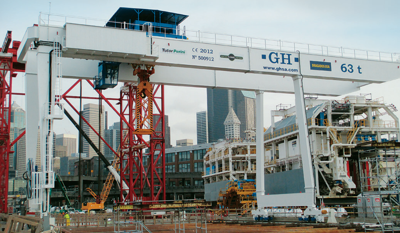
Portique GH dans l'ouvrage de génie civil à Seattle.
